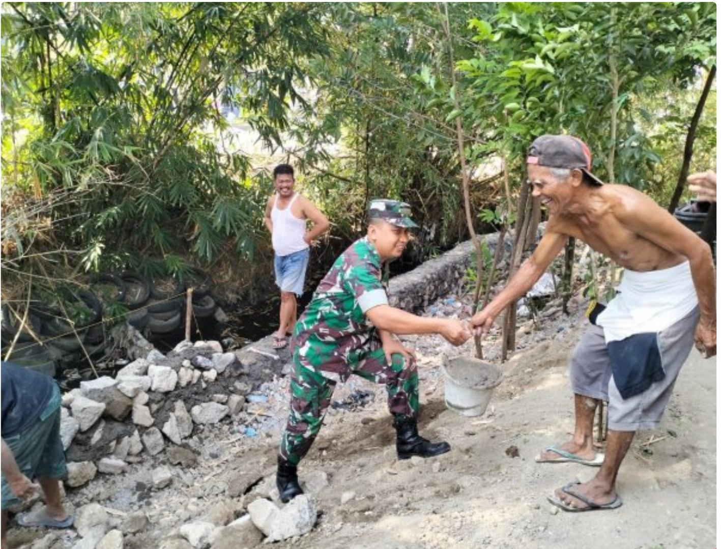
Bersama Warga, Babinsa Gotong Royong Bangun Talud Jalan Pinggir Sungai.
